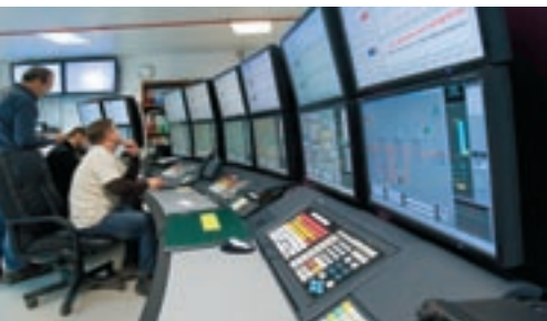
Главная операторная Карачаганакского перерабатывающего комплекса
