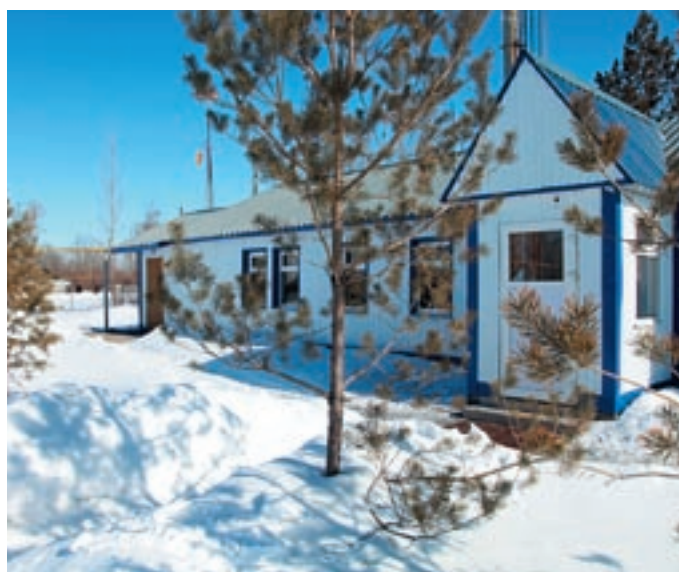
Отремонтированная начальная школа в поселке Карачаганак
