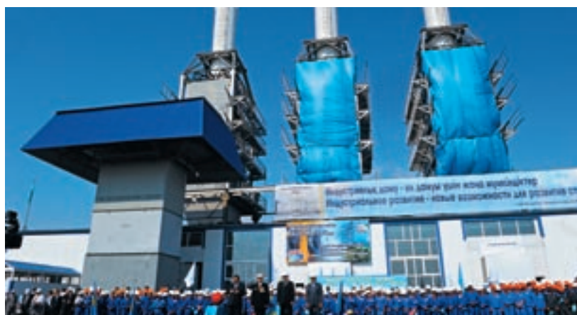
Открытие 54-мегаваттной газотурбинной электростанции в г. Уральск
